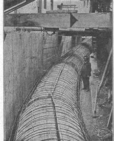
Druckrohr in Elsenbeton von 2 m Durchmesser dei Wasserkraftanlage Stöcklin & Cie., Basel 1916.
