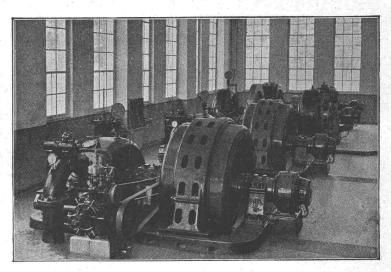
Drehstrom: 2×1300 kVA für Licht u. Kraft
