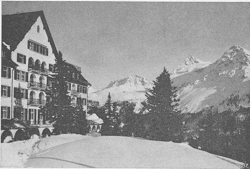
Abb. 2. Südfront, aus Südost gesehen, im Winter.
