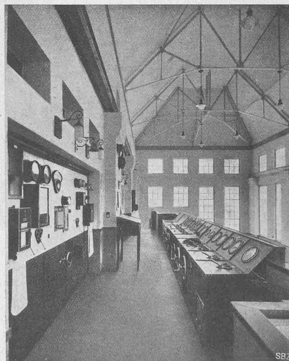
Abb. 35. Blick auf Schalttafel und Schaltpult.
