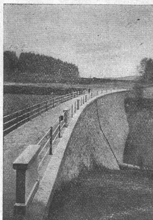
STAUMAUER u. KUBELWERK
