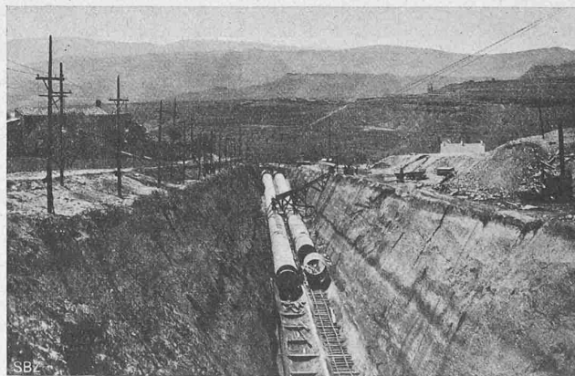
Abb. 38. Rohrleitungsmontage; Schüttgerüst für die Betonierung, die der Montagestelle auf rund 30 m Abstand folgt.
