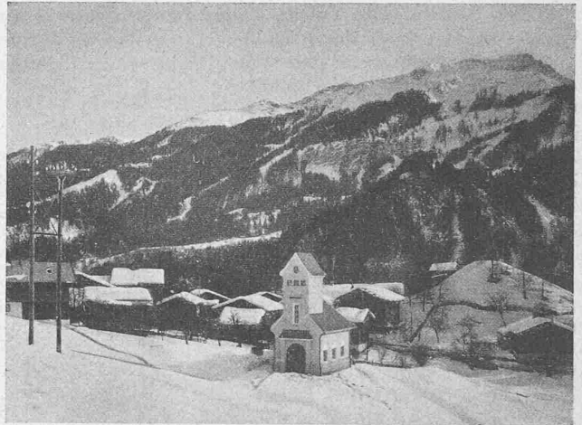
Abb. 14. Bedienungshäuschen über dem Wasserschloss in Lüen.
