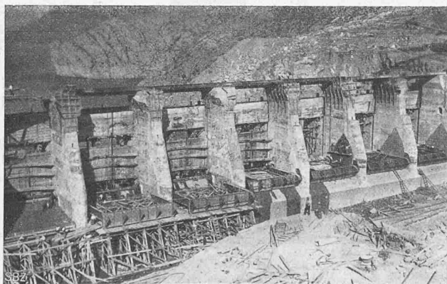
Abb. 18. Stauklappen in horizontaler Lage in Montage begriffen, im Schutze hölzerner Abschlusswände in der Dammbalken-Ebene. Klappen Nr. 4 bis 7 bereits bis an die Drehkante eingeschoben.
