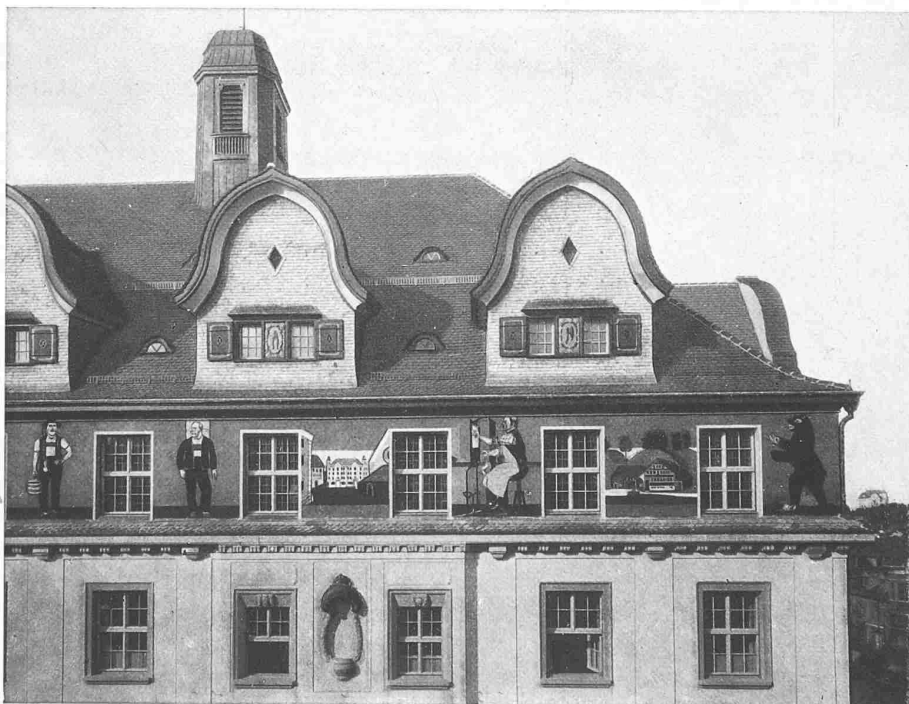
OBEN: ANSICHT VON S-W AUF SÜDSEITE DES DACHES
