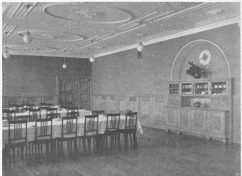
Abb. 7. Der Speisesaal im Erdgeschoss des Hochalpinen Töchterinstituts Fetan.
