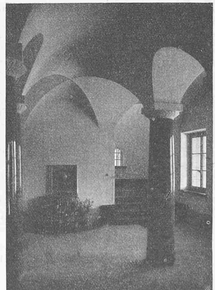
Abb. 8. Eingangshalle und Treppenaufstieg.
