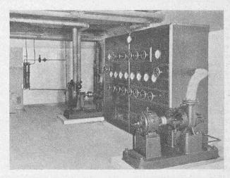
Abb. 21. Heizungs-Schalttafel und -Umlaufpumpen.
