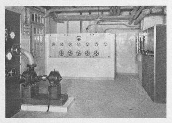
Abb. 22. Elektromotoren- und (rechts) Ventilations-Schalttafel.
