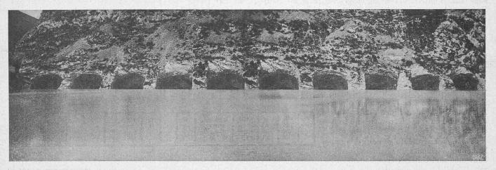
Abb. 4. Einläufe der zehn Hochwasser-Ueberlauf-Tunnels am Pantano de La Pena, vor Einbau der Stauklappen.
