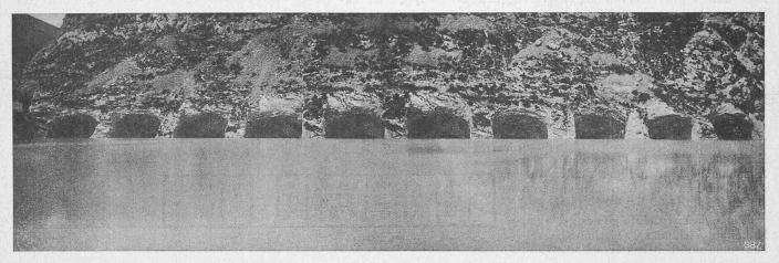
Abb. 4. Einläufe der zehn Hochwasser-Ueberlauf-Tunnels am Pantano de La Pena, vor Einbau der Stauklappen.
