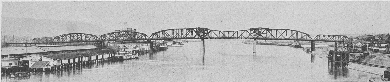
Abb. 54. Zweiflügelige Rall'sche Klappbrücke, Broadway Bridge über den Willamette River in Portland, Oregon.
