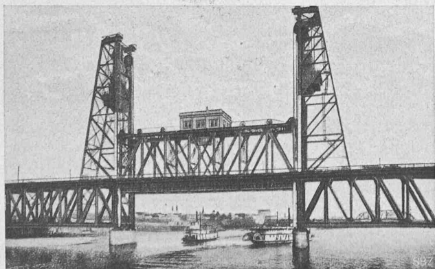
Abb. 53. Hubbrücke über den Willamette in Portland in halb geöffneten Stellung.
