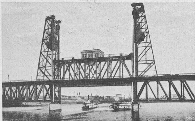
Abb. 53. Hubbrücke über den Willamette in Portland in halb geöffneter Stellung.
