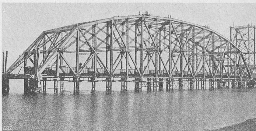
Einhängender Mittelträger der Quebec-Brücke, auf dem Montagegerüst (Nach „Eng. News“ v. 24. Aug. 1916).
