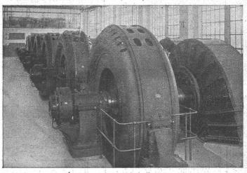
Wasserkraftzentrale Kallnach der Bernischen Kraftwerke A.G. 6 Dreiph. Wechselstrom-Generatoren von je 2640 KVA. 300 Umdr., 17 600 Volt, 40 Perioden.
