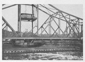
Abb. 38. Drehbrücke auf Rollenkranz im Hafen zu Boston.
