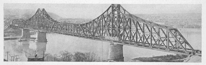
Abb. 31. Zweigeleisige Eisenbahnbrücke über den Ohlo bei Beaver. - Mittelöffnung 235 m, Hauptträgerabstand 10,5 m.
