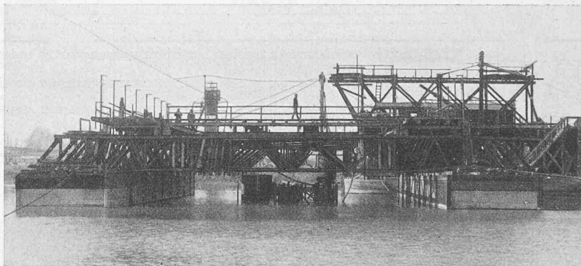
Abb. 26. Schwimmgerüst des beweglichen Caisson.
