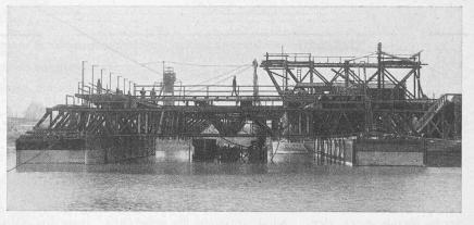
Abb. 26. Schwimmgerüst des beweglichen Caisson.
