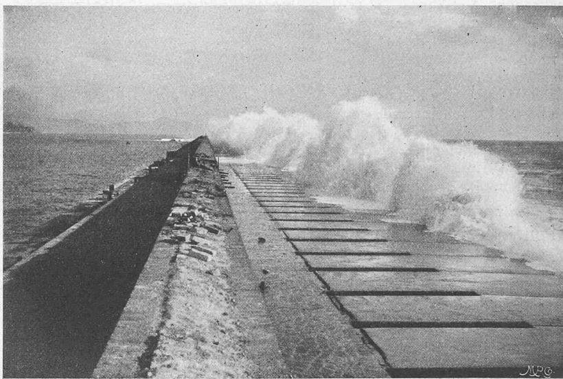
Abb. 20. Brandung am Molo Galliera in Genua (vergl. Profil auf Seite 91). Links der Vorhafen, rechts offenes Meer. Trotz nur mässig bewegter See starke Brandung, infolge Auflaufens der Wogen auf die flache Dammböschung (vergl. S. B. Z. Okt./Nov. 1902).
