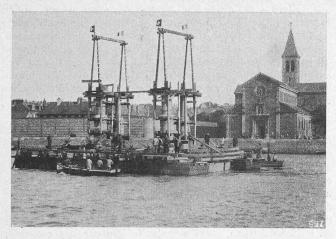
Abb. 9. Ausfahren eines Hohlblockes zwischen Kähnen.
