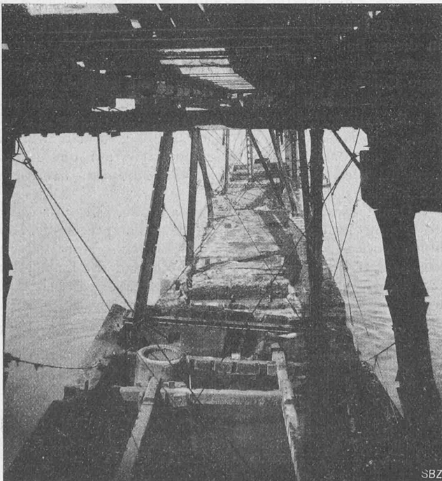
Abb. 10. Abgestellte Hohlblöcke, darüber Baugerüst.
