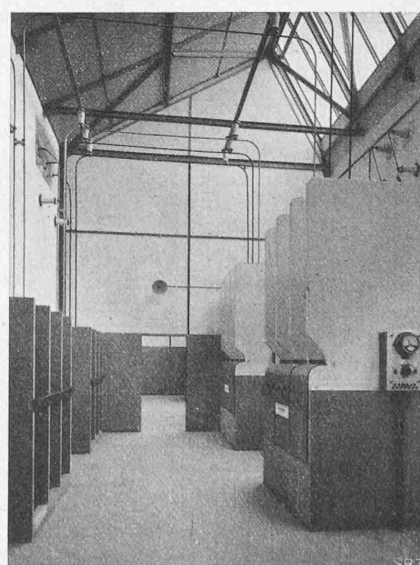
Abb. 11. Schalter der abgehenden Linien.
