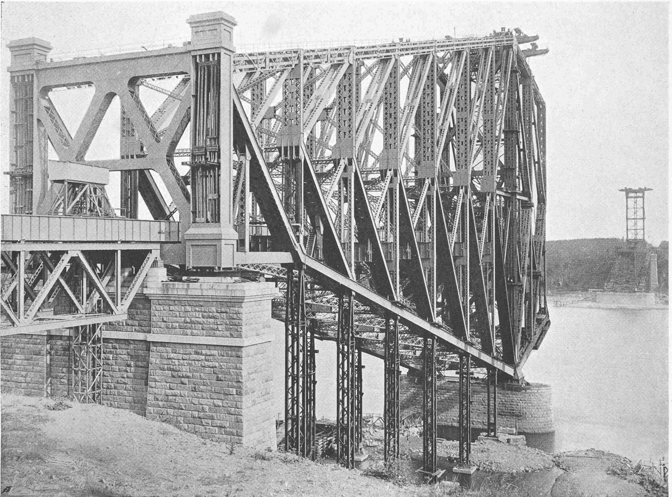
LINKSUFRIGER AUSLEGERARM DER ST. LAWRENCE-BRÜCKE BEI QUEBEC, CANADA
