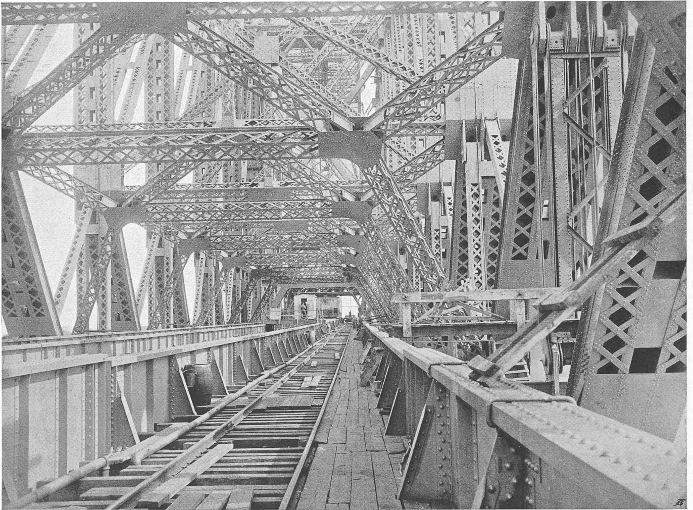
Abb. 25. Einblick in den linksufrigen (nördlichen) Auslegerarm der St. Lawrence-Brücke. Aufnahme vom 3. August 1915.
