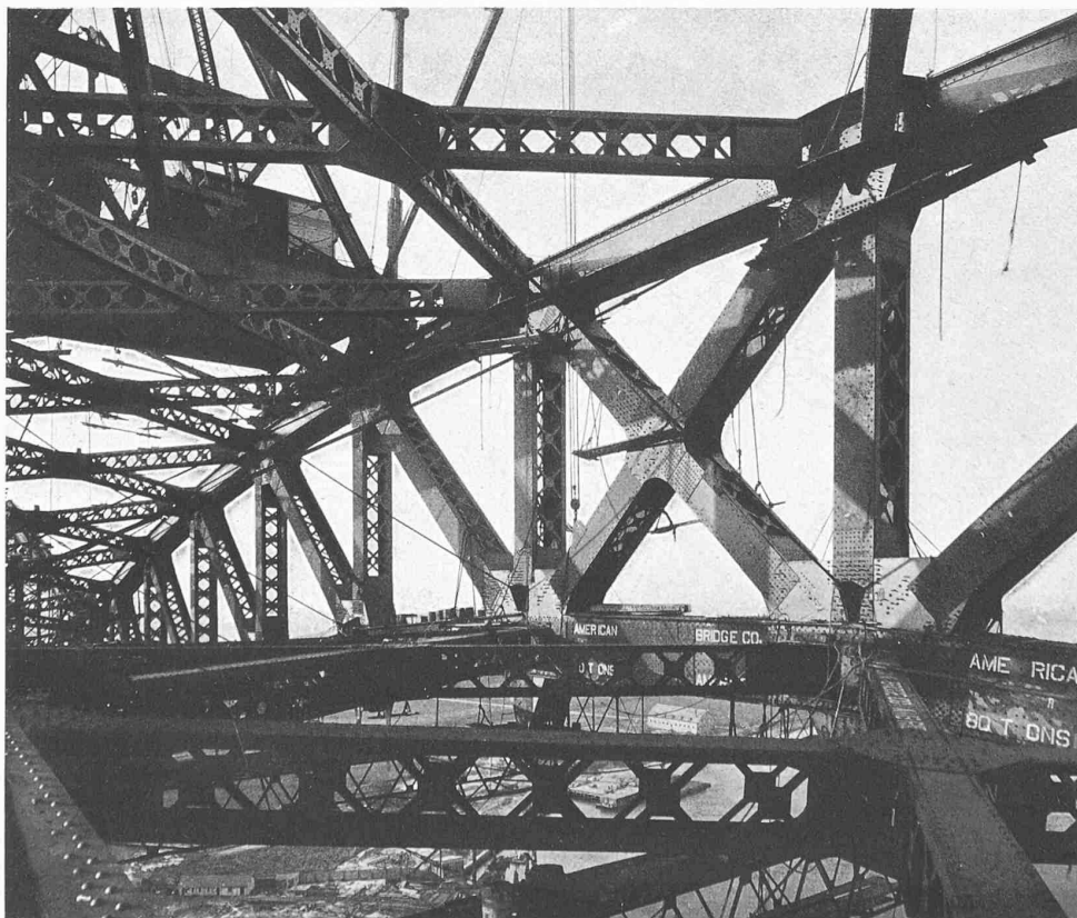
Abb. 18. Blick in das Brückeninnere am Bogenscheitel; Knotenpunkte vernietet.
