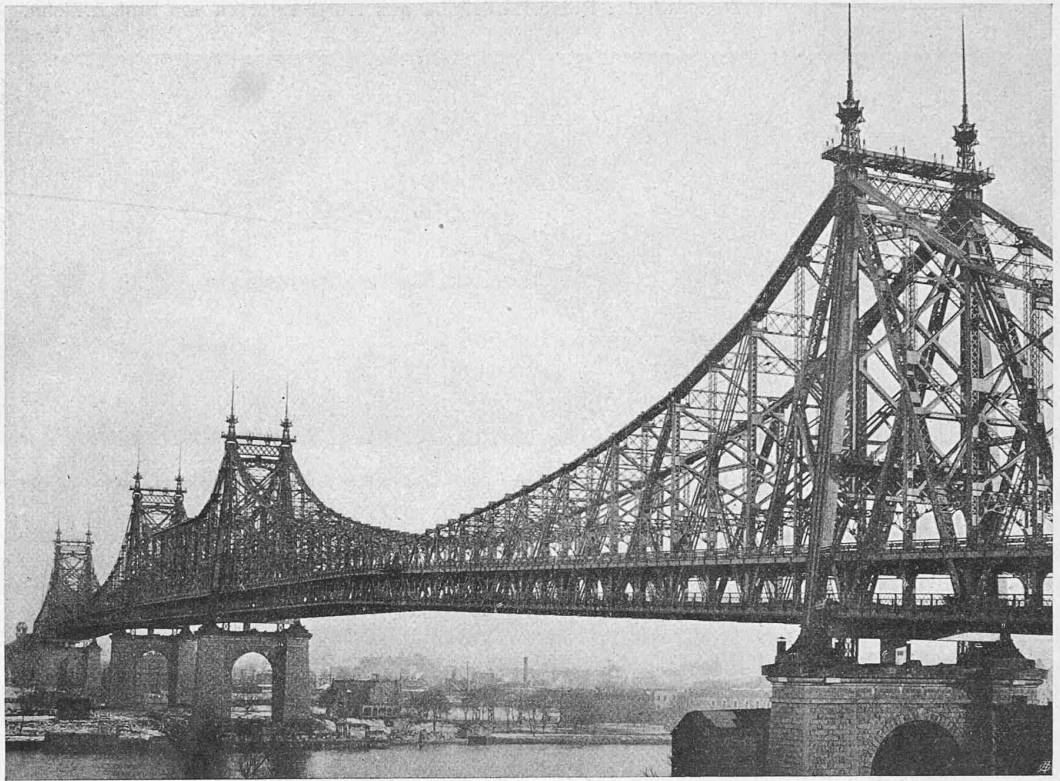
Abb. 14. Queensborough-Brücke in New York, eröffnet 1909, Hauptöffnungen 360 m.
