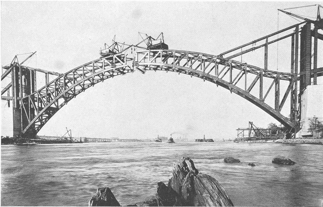
Abb. 17. Am 29. September 1915, unmittelbar vor Bogenschluss.
