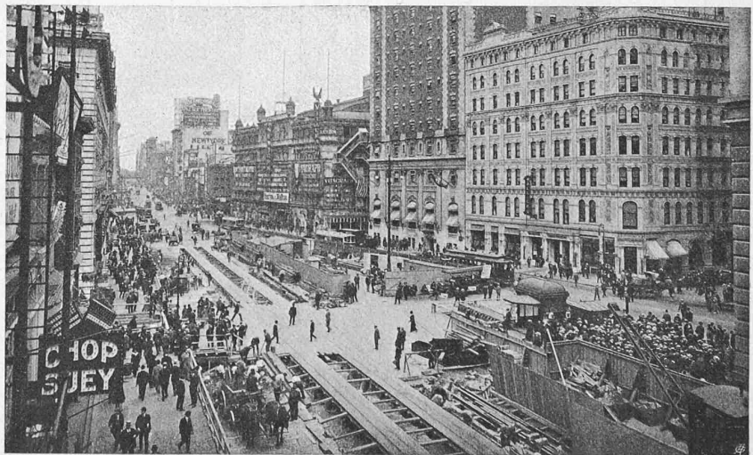
Abb. 5. Bohlen-Abdeckung zum Bau der Untergrundbahn (7. Av., 42. Str.).
