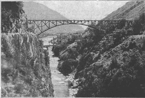
Brücke über den Isorno bei Intragna der Ferrovia Locarno-Domodossola. Totale Spannweite 132 m. Höhe über Flusssohle ca. 80 m. Stand der Montage Ende Mai 1916.
