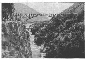
Brücke über den Isorno bei Intragna der Ferrovia Locarno-Domodossola. Totale Spannweite 132 m. Höhe über Flussohle ca. 80 m. Stand der Montage Ende Mai 1916.
