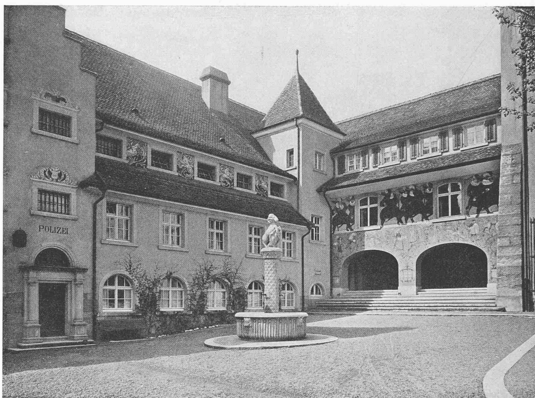
HOFANSICHT GEGEN SÜDWEST (OBEN)
