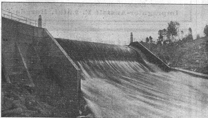
Selbsttätiges Ueberfallwehr Osfaldet für Aamot kommunale Elektrizitätsverk (Norwegen)
