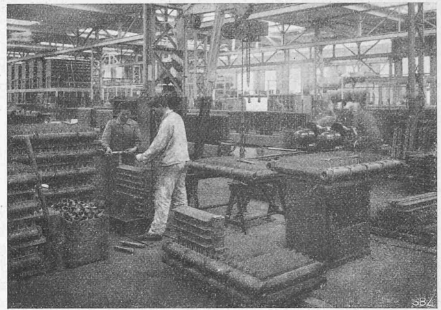
Abb. 18. Zusammen-Nippeln der Elemente zu Radiatoren.
