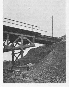
wurde zwischen dem letzten Querträger und dem anschliessenden Damme ein Schleppträger gelegt, und nun unter diesem das Widerlager abgebrochen und erneuert. Während dieses Bauzustandes
