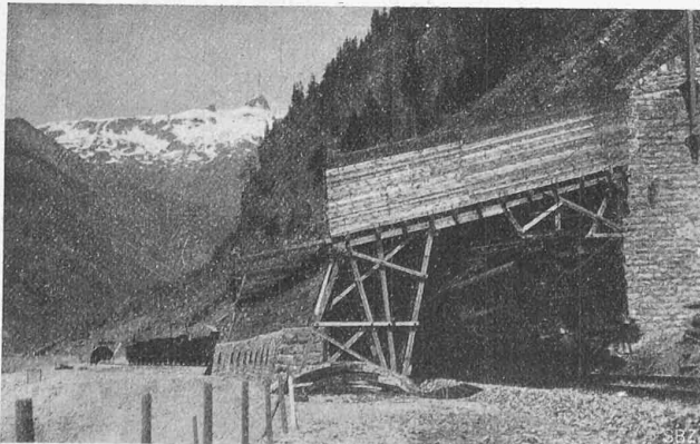
Abb. 34. Prov. Holzgalerie im Stockgraben-Lawinezug.
