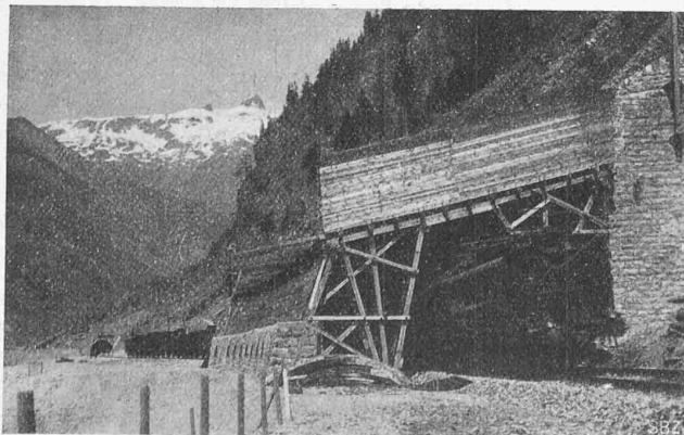
Abb. 34. Prov. Holzgalerie im Stockgraben-Lawinenzug.
