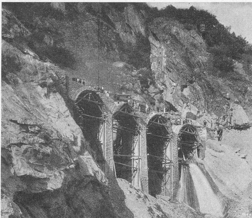
Abb. 3. Mundbach-Viadukt der Lötschbergbahn, im Bau.
