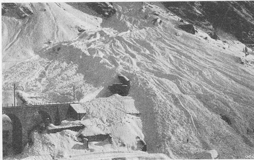
Abb. 12. «Rote Lawine» 1913, Lanza-Viadukt und oberes Rotlauentunnel-Portal.
