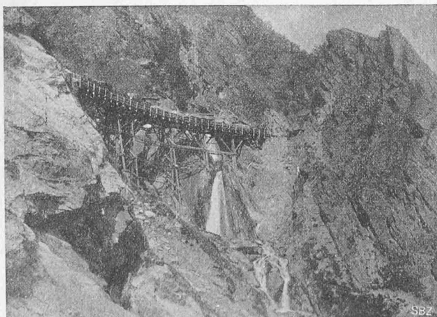
Abb. 5. Dienstbahn-Viadukt über den Mundbach.
