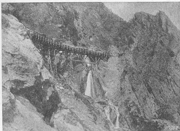
Abb. 5. Dienstbahn-Viadukt über den Mundbach.
