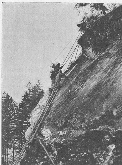
Abb. 6 und 7. Mechanische Bohrung am Felsvorsprung der „Nase“.
