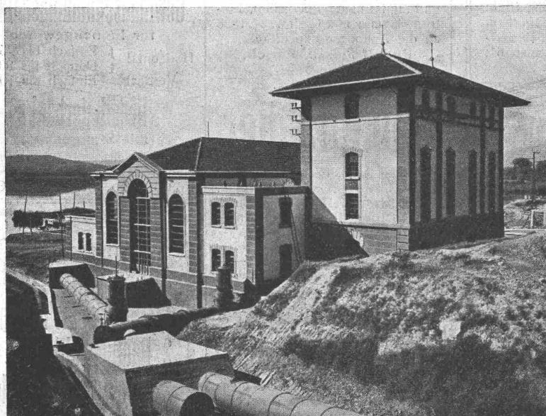
Hydraulische Akkumulierungsanlage Viverone (Italien). Maschinenhaus am Viverone See.
