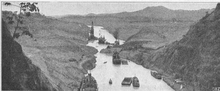
Abb. 3 wie Abb. 2, aber im August 1915, mit beidseitigen Rutschungen.
