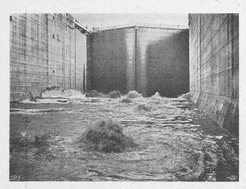
Abb. 8. Erste Füllung einer Miraflores-Schleusen-Kammer.
