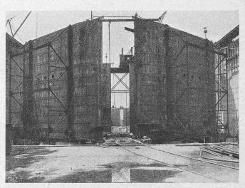
Abb, 7. Schutztor der Pedro Miguel-Schleuse im Bau.
