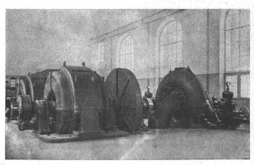
Hydroelektrische Zentrale Massaboden der S.B.B. für den Betrieb im Simplon-Tunnel: 2 Dreiphasen-Generatoren von je 2700 kVA, 500 Umdr., 3300 Volt, Frequenz 169/8
