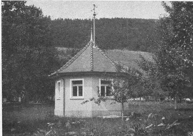
Abb. 3 Ansicht des Pumpen-Häuschens.
