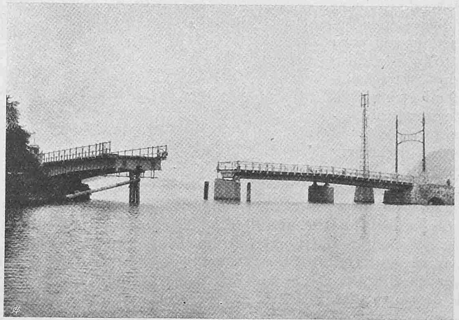
Abb. 11. Die neue Drehbrücke in geöffnetem Zustand, links deren Stirnende mit den Laufrädern a .
