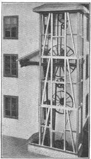
Umänderung einer stehenden Welle mit konischen Rädern in vertikale Lenix-Riementriebe in einer Baumwollweberei Direkter Antrieb bei grössten Uebersetzungs-Verhältnissen und kleinsten Achsendistanzen.
