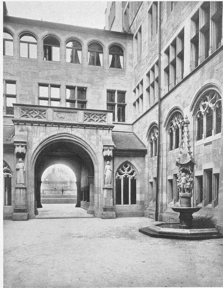
DER HOF GEGEN DAS STADTHAUS, ERBAUT 1900
