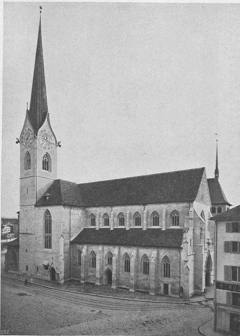
Abb. 6. Ansicht der restaurierten Nordfront, gegen den Münsterhof.
