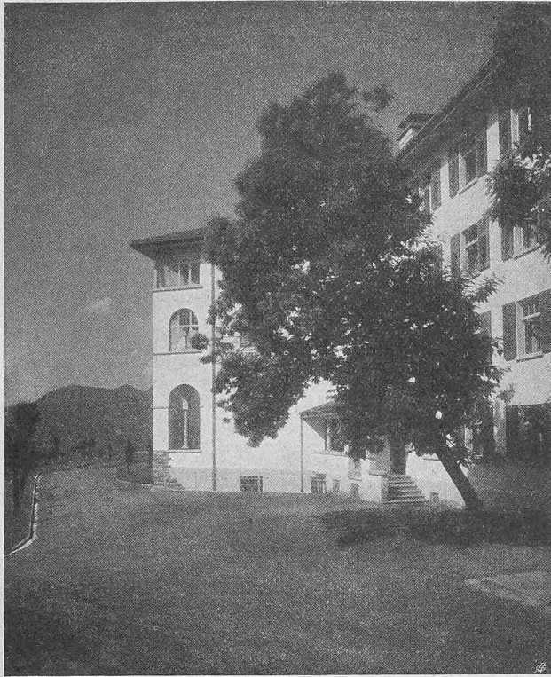
Abb. 3. Ost-Ecke des Hauptgebäudes; rechts das Dienstgebäude.
