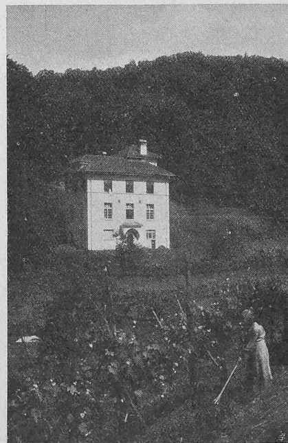
Abb. 4. Das Waschhaus von Süden.
