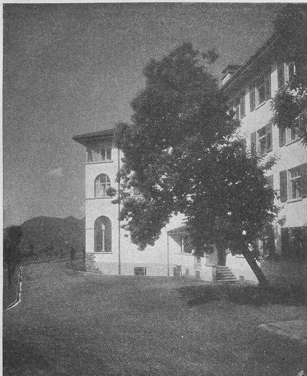
Abb. 3. Ost-Ecke des Hauptgebäudes; rechts das Dienstgebäude.
