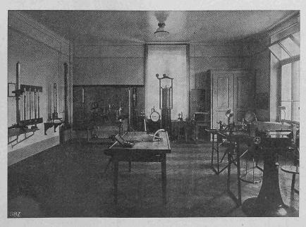
Abb. 16. Raum 35, für barometrische, manometrische und hygrometrische Messungen.
