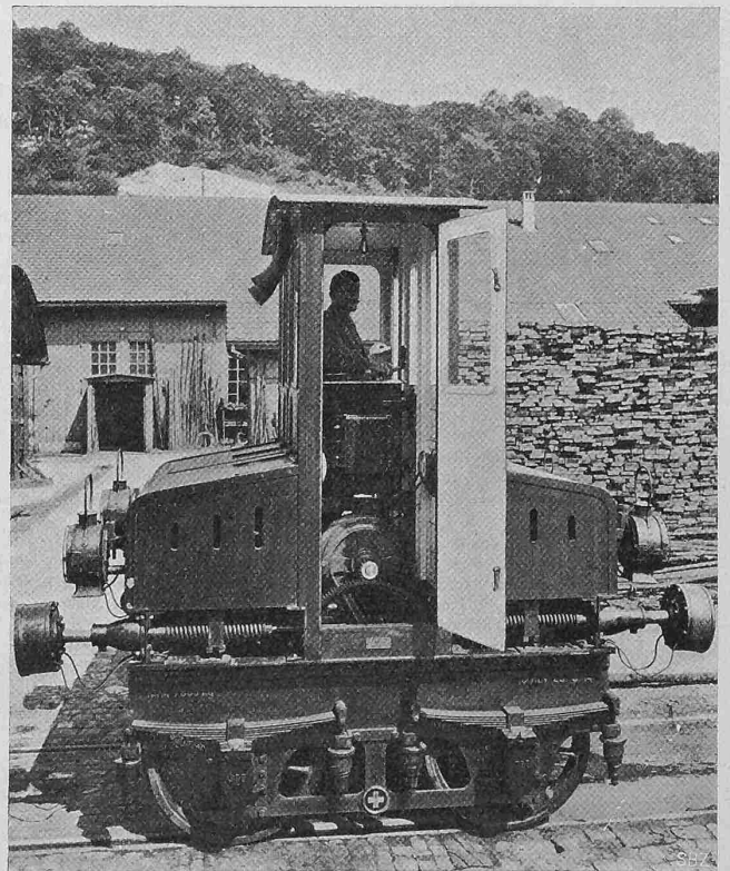
Abb. 4 und 5. Akkumulatoren-Werkstatt-Lokomotive, Masstab 1:40. — Gebaut von der Werkstätte Olten der S. B. B.
