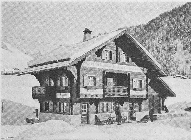
Abb. 34. Stationsgebäude Langwies der Chur-Arosa-Bahn. Architekt Alfons Rocco in Arosa.
