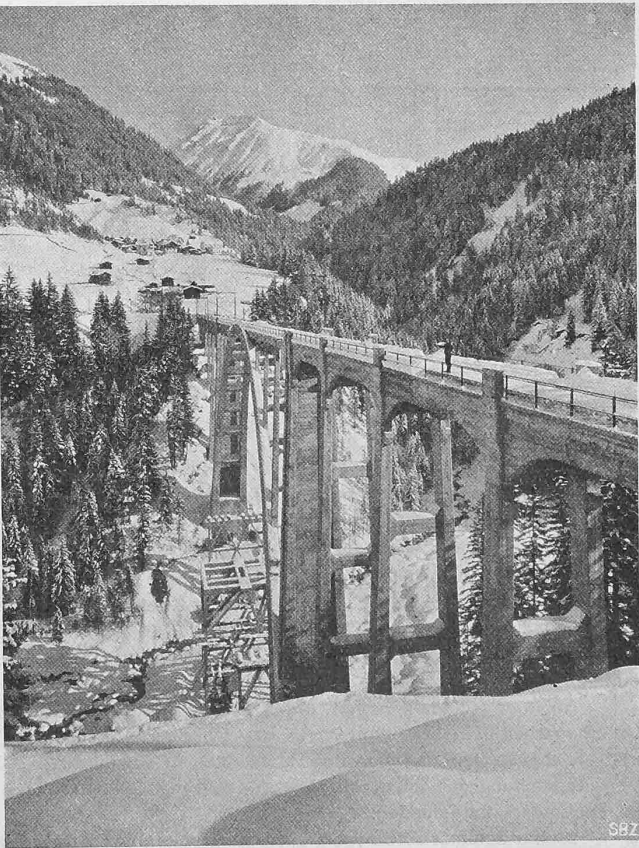
Abb. 31. Langwieser-Viadukt, gegen Osten gesehen. (Unter dem Bogen der Eisenbeton-Unterbau des Baugerüsts.)
