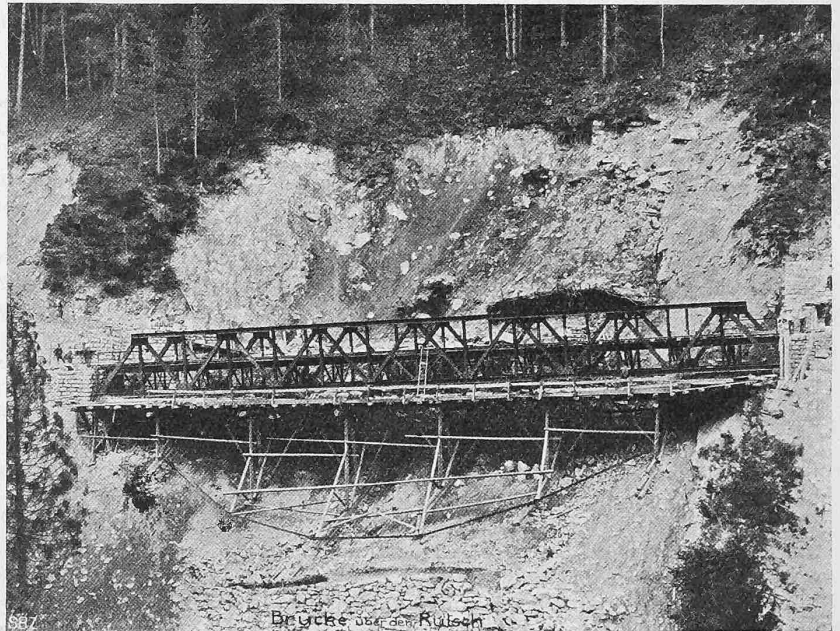
Abb. 5. Brücke über den Rutsch bei Km. 3,78. Spannweite 46,0 m
