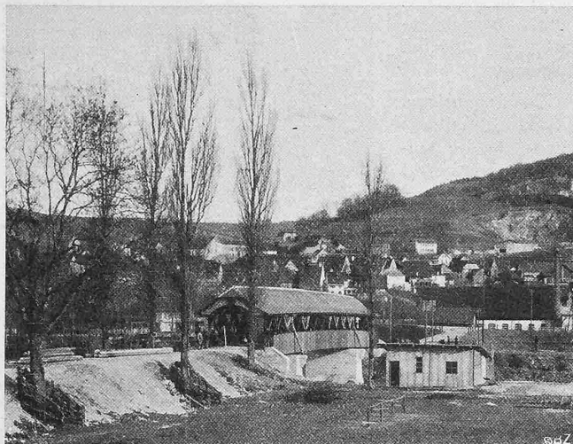
Abb. 10. Die Brücke und Münchenstein von Westen.
