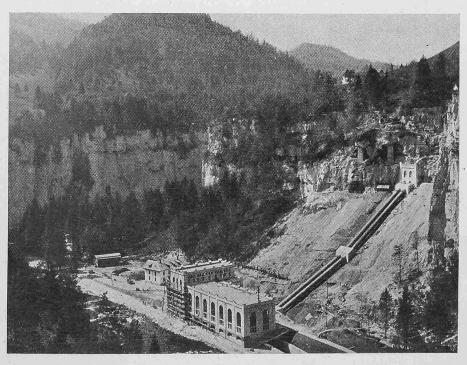
Abb. 15. Schieberhaus, Druckleitung und Zentrale Refrain am Doubs,
