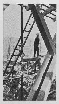
Abb. 8. Anspannen der Zugstangen unter Benützung von Mantel'schen Spannungsmessern.
