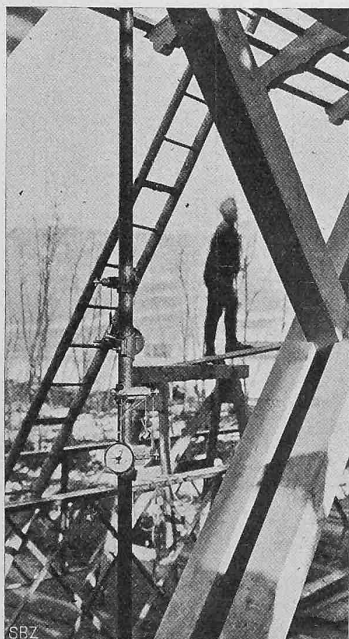
Abb. 8. Anspannen der Zugstangen unter Benützung von Mantel'schen Spannungsmessern.
